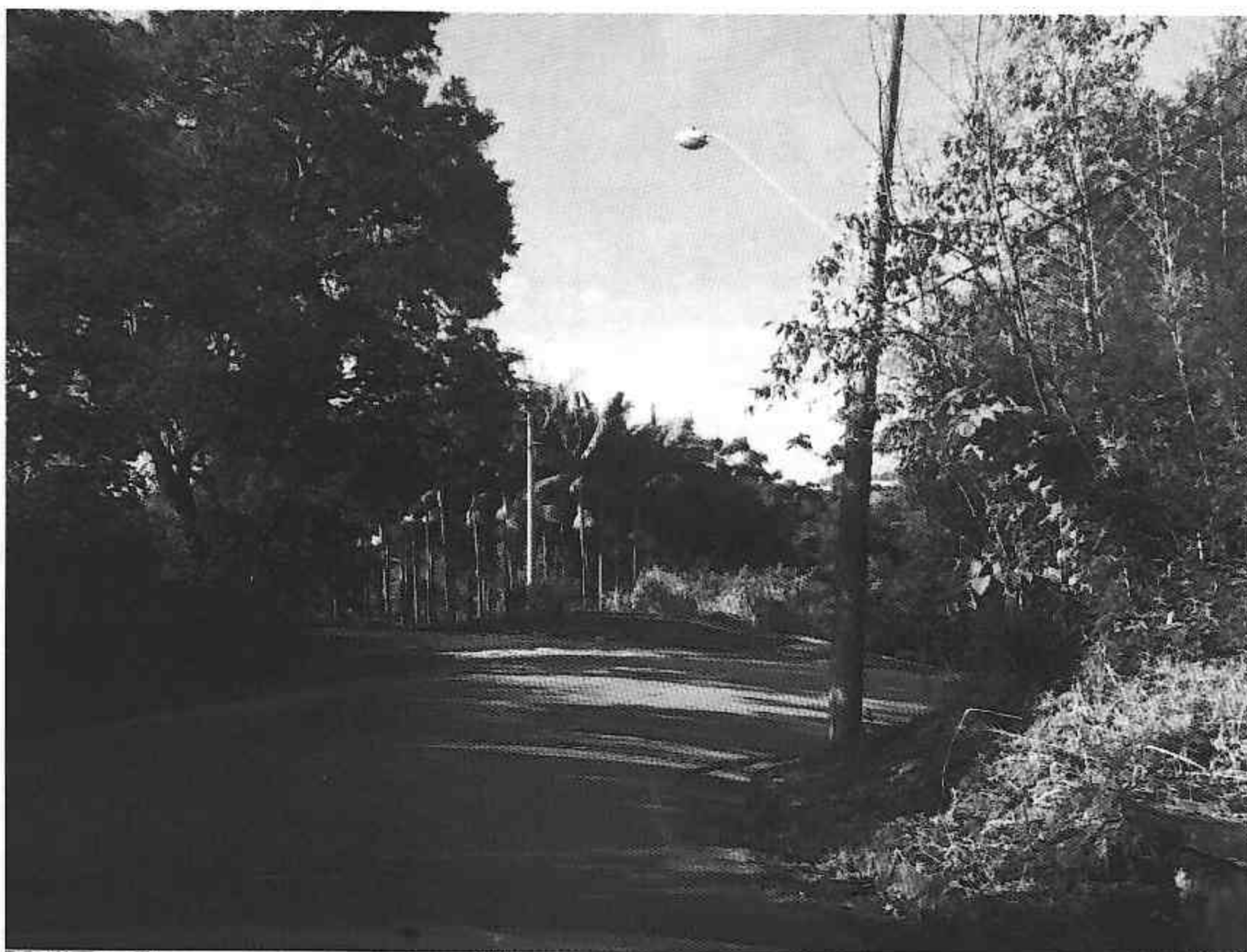
Manutenção da grade de proteção metálica da estrada Taboão do Paratei - Taboão
