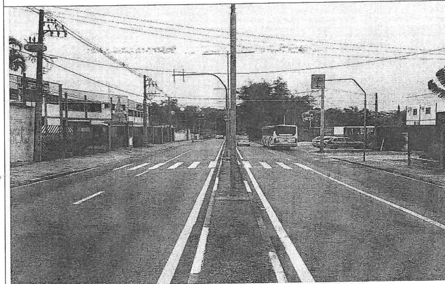
DATA 06/06/2017 – CONSTRUÇÃO DE LOMBADA, RAMPA DE ACESSIBILIDADE, IMPLANTAÇÃO DE ILUMINAÇÃO PARA FAIXA DE PEDESTRE E SINALIZAÇÃO VERTICAL (A-18) EM PP E REVITALIZAÇÃO DA FAIXA DE PEDESTRES NA ALTURA DO Nº 7170
