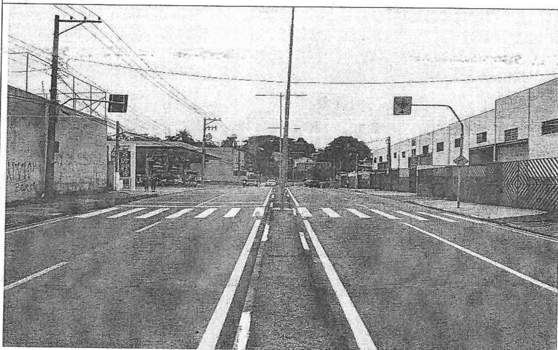
DATA 26/09/2017 - CONSTRUÇÃO DE LOMBADA, RAMPA DE ACESSIBILIDADE, IMPLANTAÇÃO DE ILUMINAÇÃO PARA FAIXA DE PEDESTRE E SINALIZAÇÃO VERTICAL (A-18) EM PP E REVITALIZAÇÃO DA FAIXA DE PEDESTRES NA ALTURA DO Nº 6188
