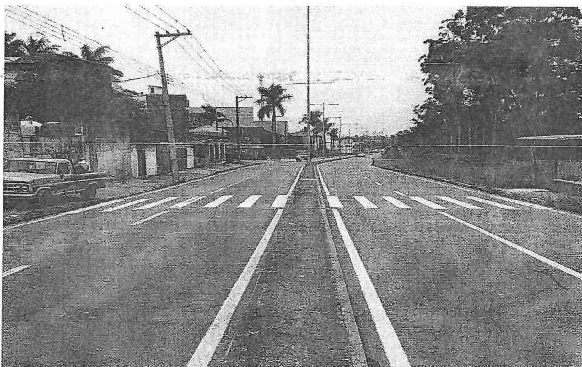
DATA 26/09/2017 – CONSTRUÇÃO DE LOMBADA, RAMPA DE ACESSIBILIDADE, IMPLANTAÇÃO DE ILUMINAÇÃO PARA FAIXA DE PEDESTRE E SINALIZAÇÃO VERTICAL (A-18) EM PP E REVITALIZAÇÃO DA FAIXA DE PEDESTRES NA ALTURA DO Nº 5478
