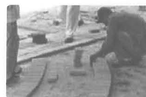
Assentamento da primeira fiada
