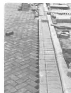
Ajuste e arremate dos blocos
