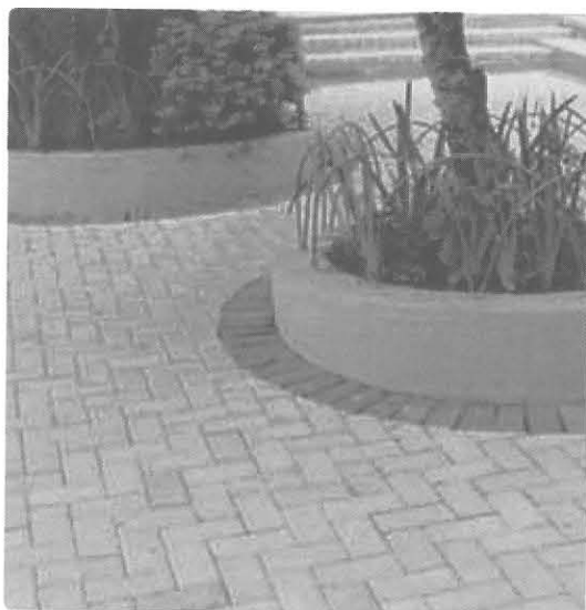
Acabamento junto ao confinamento interno
