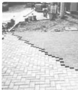
Ajuste e arremate dos blocos
