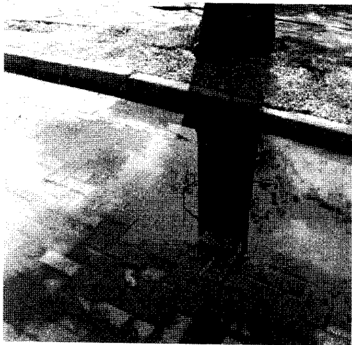
Figura 14 - Pavimento permeável com colmatagem das juntas devido ao acúmulo de sedimentos
