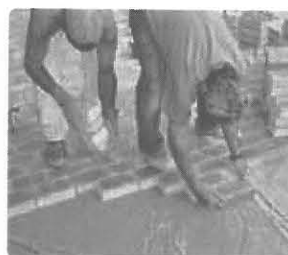
Frente de serviço organizada para assentamento dos blocos
