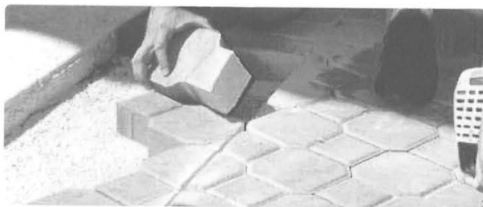
Corte do bloco no piso
