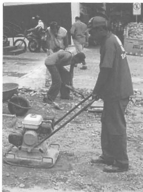
Compactação do subleito
