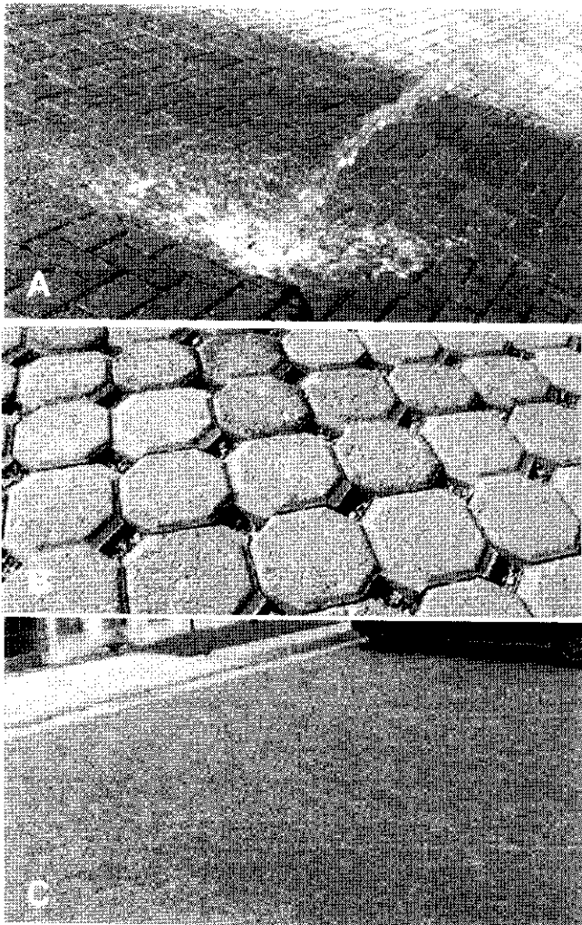
Figura 5 – Tipos de revestimento para pavimento intertravado permeável (A) peças de concreto com junta alargada. (B) peças de concreto com aberturas (C) peças de concreto poroso
