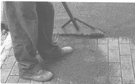
Selagem do pavimento
