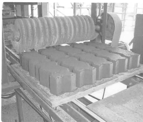
Fabricação com máquinas vibro-compressoras
