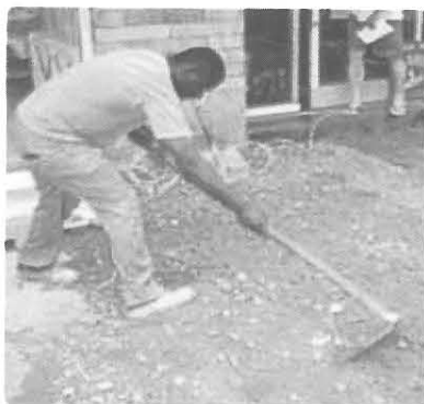
Espalhamento da bica corrida
