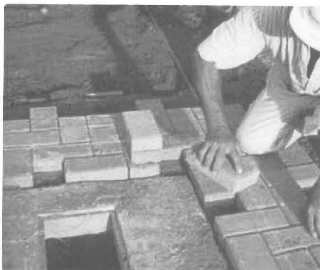
Acabamento junto ao confinamento interno
