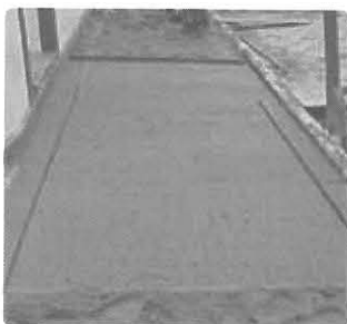
Camada de assentamento
