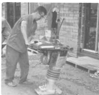
Compactação de bica corrida
