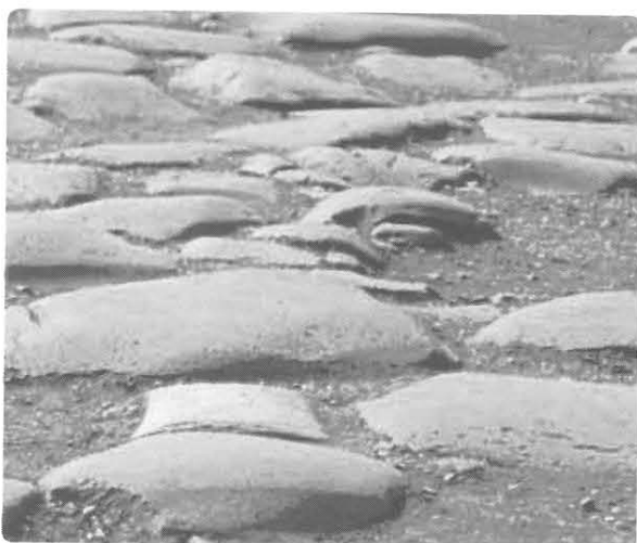
Pavimento intertravado de pedras talhadas em forma de prisma regular
