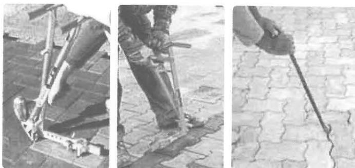
Retirada dos blocos danificados
