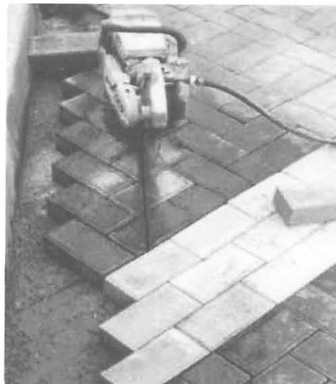
Corte do bloco no piso
