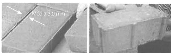
Junta entre blocos – média 3 mm
