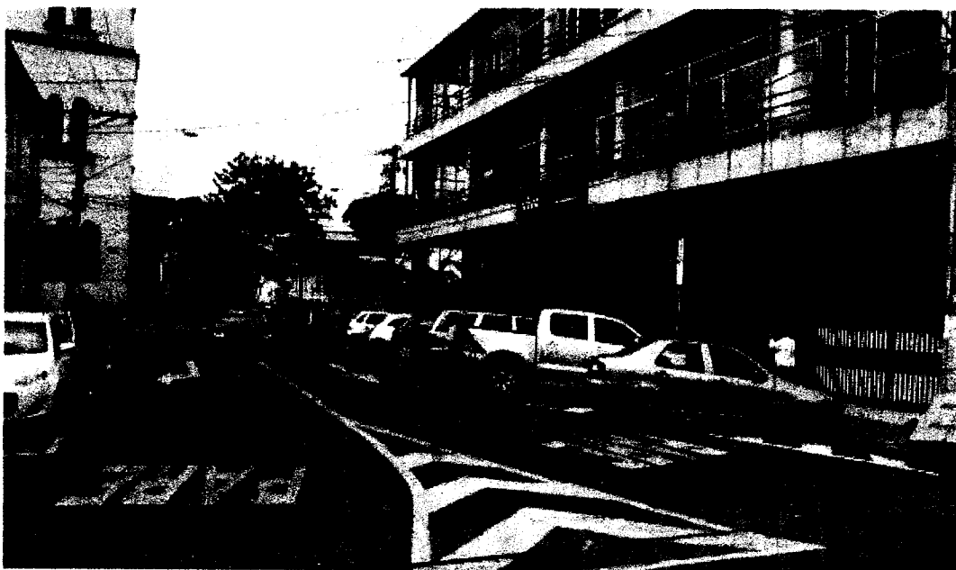
Figura 17 – Rua existente e de passagem situada defronte para o Edifício da Telefônica – oficialmente denominada como Praça Monsenhor Roque Pinto de Barros
