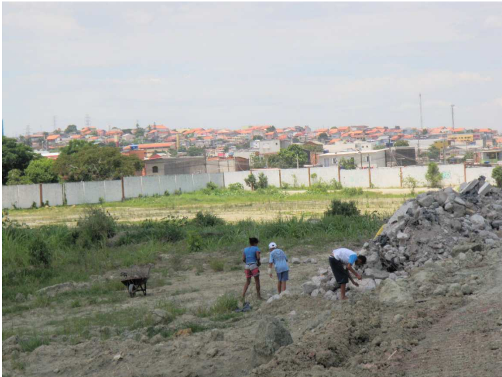
Foto 27 Outra vista da colocação de entulho no terreno
