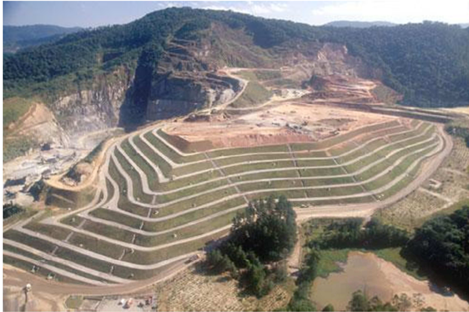
Figura 19 Aterro Sanitário CDR (Soares, 2010)
