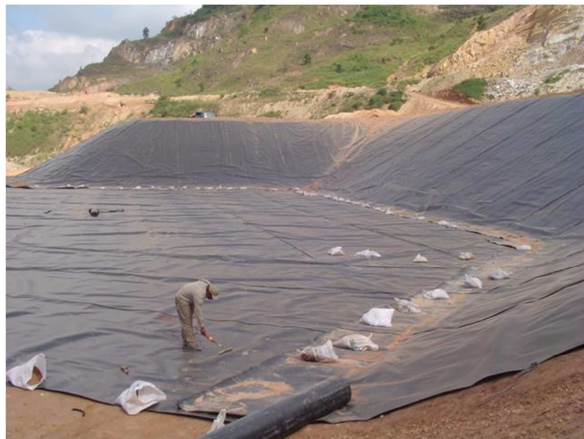
Figura 20 Impermeabilização de fundo CDR - (Soares, 2010)
